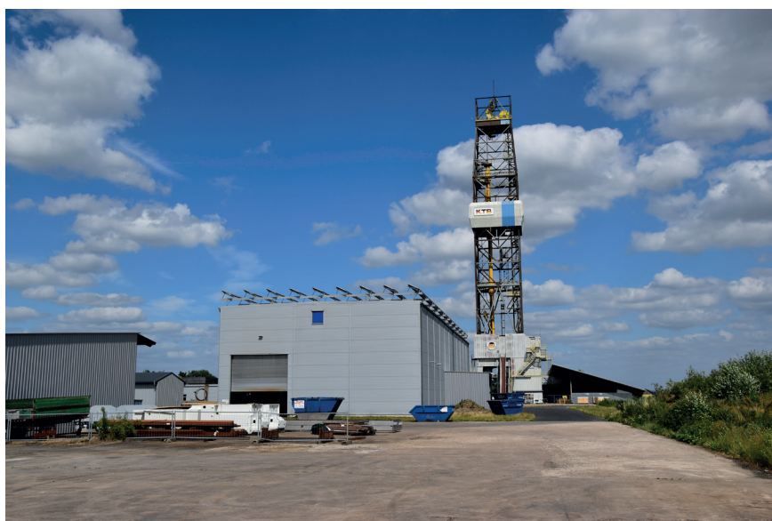
Obr. 12. V mieste dosiaľ najhlbšieho kontinentálneho vrtu pri Windischeschenbachu, ktorým bola po štyroch rokoch vrtných prác dosiahnutá hĺbka vyšie 9 km, ostala pri najväčšej pozemnej vrtnéj súprave na svete zachovaná aj 83 m vysoká vrtná veža.
