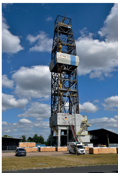
Obr. 12. V mieste dosiaľ najhlbšieho kontinentálneho vrtu pri Windischeschenbachu, ktorým bola po štyroch rokoch vrtných prác dosiahnutá hĺbka vyšie 9 km, ostala pri najväčšej pozemnej vrtnéj súprave na svete zachovaná aj 83 m vysoká vrtná veža.
