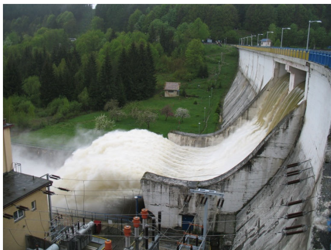
Obr. 13 Viacúčelové vodné dielo Orava počas povodňových prietokov v roku 2010 (foto: Caban, J.)
