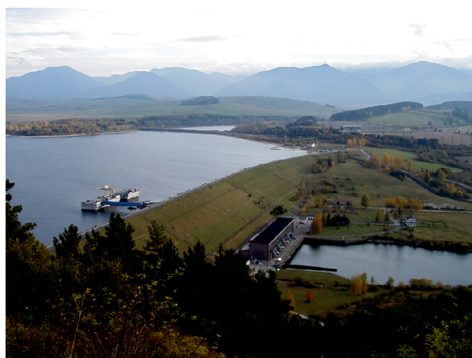
Obr. 17 Viacúčelové vodné dielo Liptovská Mara (foto: Bednárová, E.)
