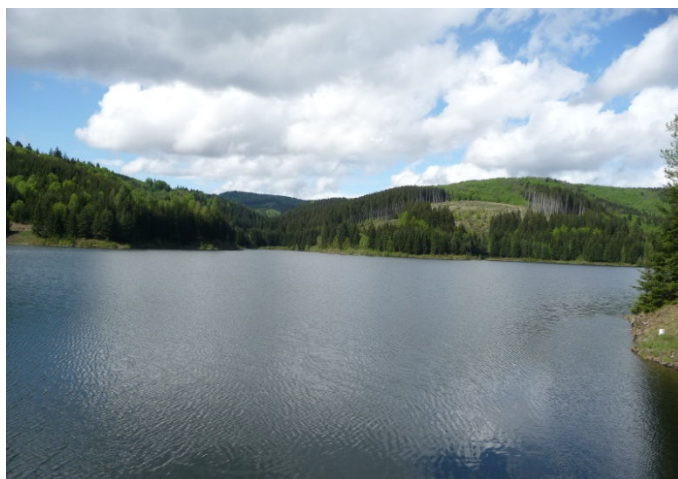
Obr.15 Vodárenská nádrž Hriňová (foto: Bednárová, E.)
