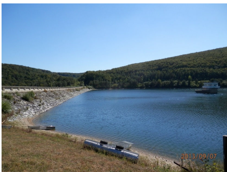
Obr. 19 Vodárenská nádrž Bukovec II (foto: Bednárová, E.)
