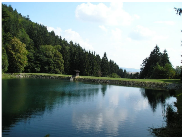
Obr.1 Priehrada Veľká Vodárenská (1510) (foto: Lipták, B.)
