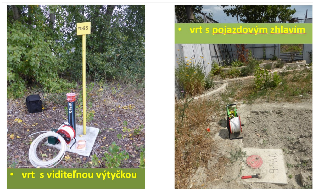
Obr. 3 Novo realizovaný monitorovací vrt VN48-5 (Matador) s výtyčkou a novo realizovaný vrt VN6-6 (CHZJD) s pojazdovým zhlavím
