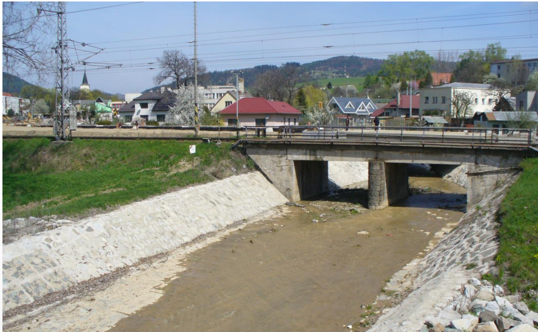
Tvrdé opevnenie celého koryta (potok v Lipanoch). Foto: Eva Bulánková
