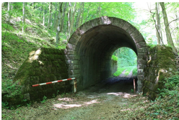
Nedokončenú železničnú trať z Muráňa do Tisovca (budovala sa počas II. svetovej vojny) dokumentujú nefunkčné tunely a terénne zárezy a násypy
