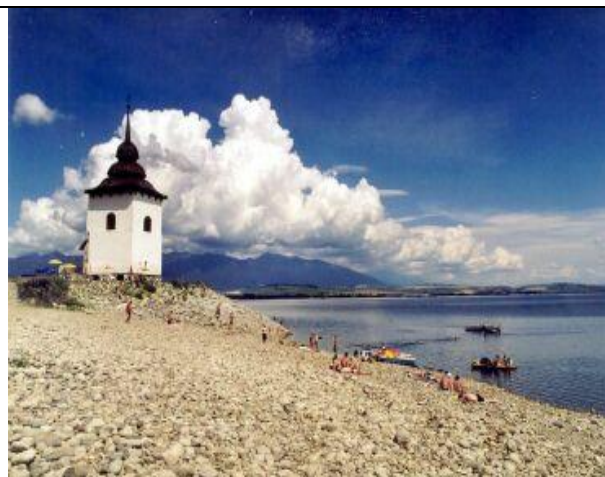
Vodná nádrž Liptovská Mara
