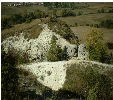
Gravitačne rozvolnený svah budovaný zlepencami
