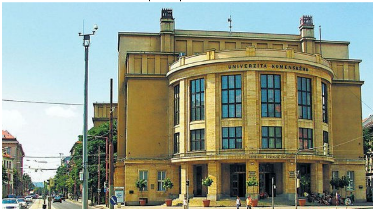
Obr. 13 Budova Univerzity Komenského v Bratislave obložená travertínom
