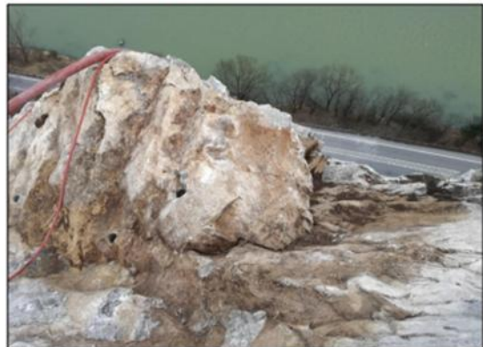
Obr. 15 a 16 Odrazenie časti bloku II v objeme 10,7 m 3
