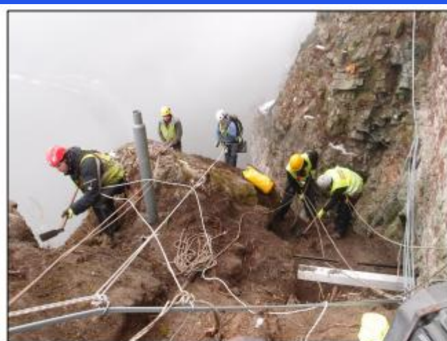
Obr. 12 Čistenie skalnej steny na bloku II
