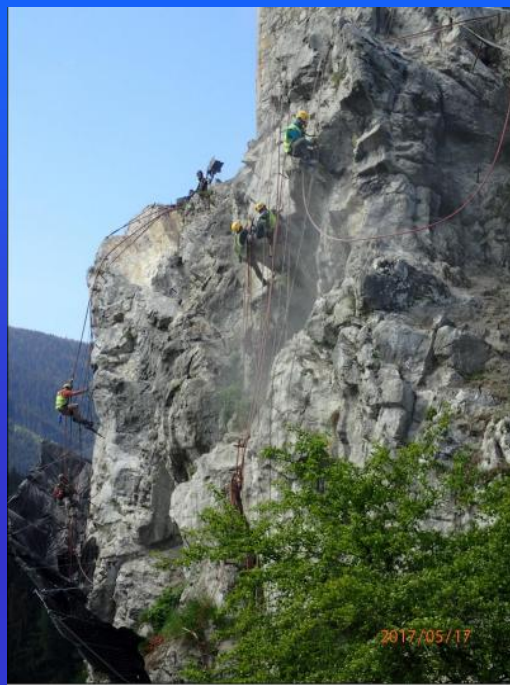
Obr. 17 Celkový pohľad na odrazenú časť bloku II
