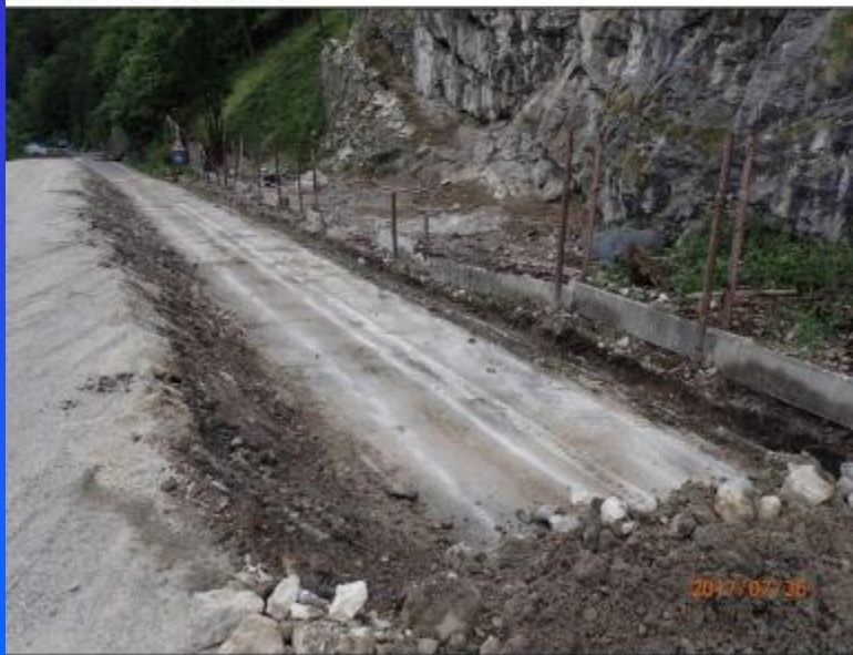
Obr. 48 Čištění akumulačního prostoru a odstraňování ochranného poštáře
