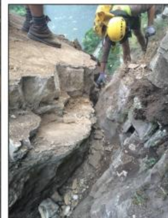
Obr. 24, 25, 26 a 27 Celkový pohľad na kritický blok a prúbeh jeho shazovania
