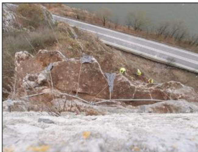
Obr. 13 Čistenie skalnej steny na bloku I
