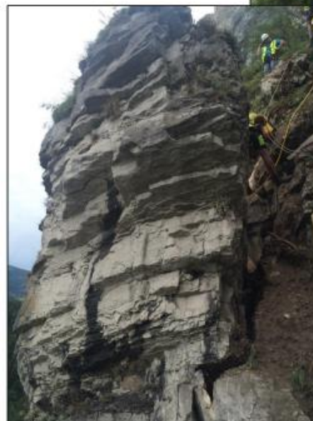
Obr. 24, 25, 26 a 27 Celkový pohľad na kritický blok a prúbeh jeho shazovania
