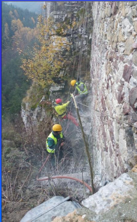
Obr. 12 Čistenie skalnej steny na bloku II
