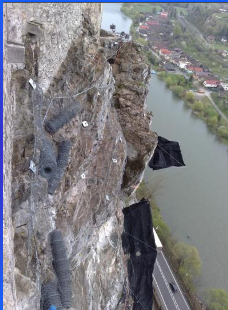
Obr. 55 Role sietí Steelgrid pred rozbalením na bloku IV
