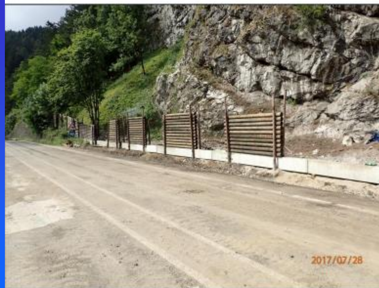
Obr. 55 a 56 Oprava a zpětná montáž palisád
