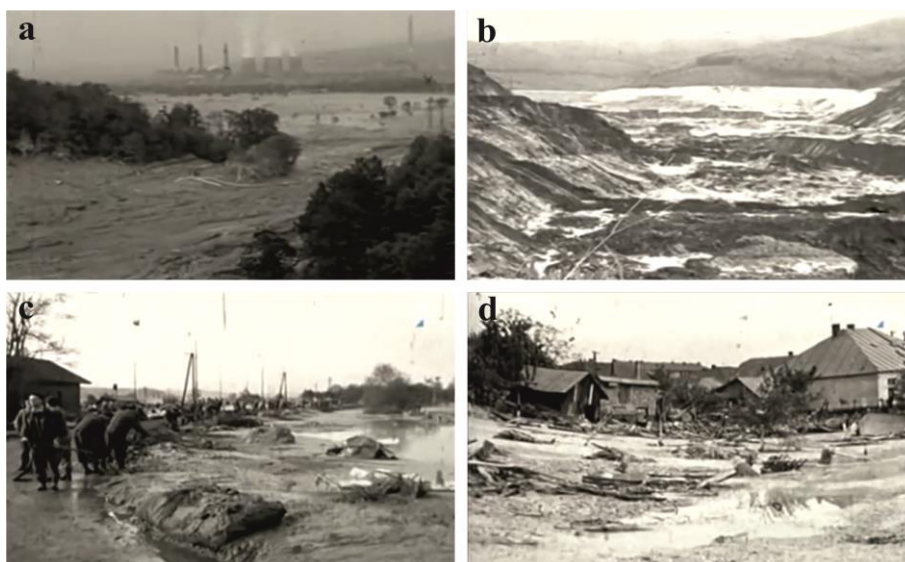
Obr. 6: Pohľad na rozplavený popolový materiál po pretrhnutí hrádze
