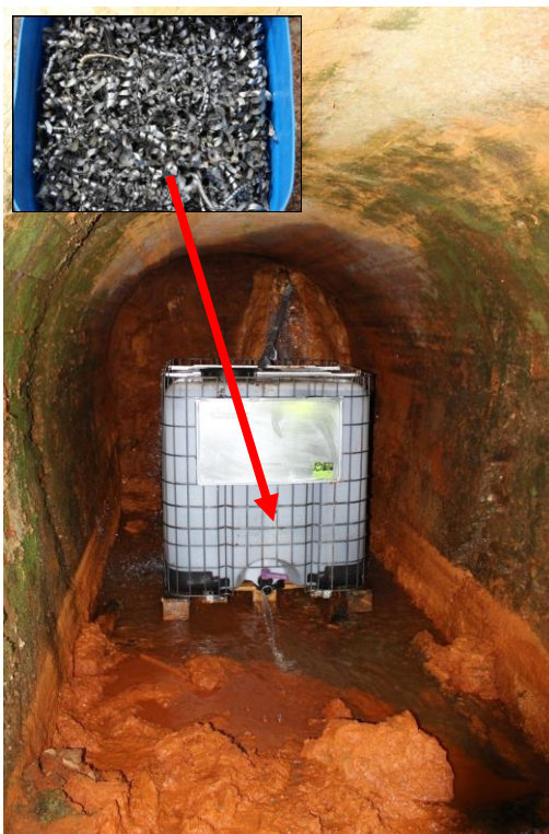
Obr. 4: Štôľňa Agnes s experimentálnym kontajnerom na pasívne čistenie vôd (náplň kontajnera - odpadové Fe špony)
