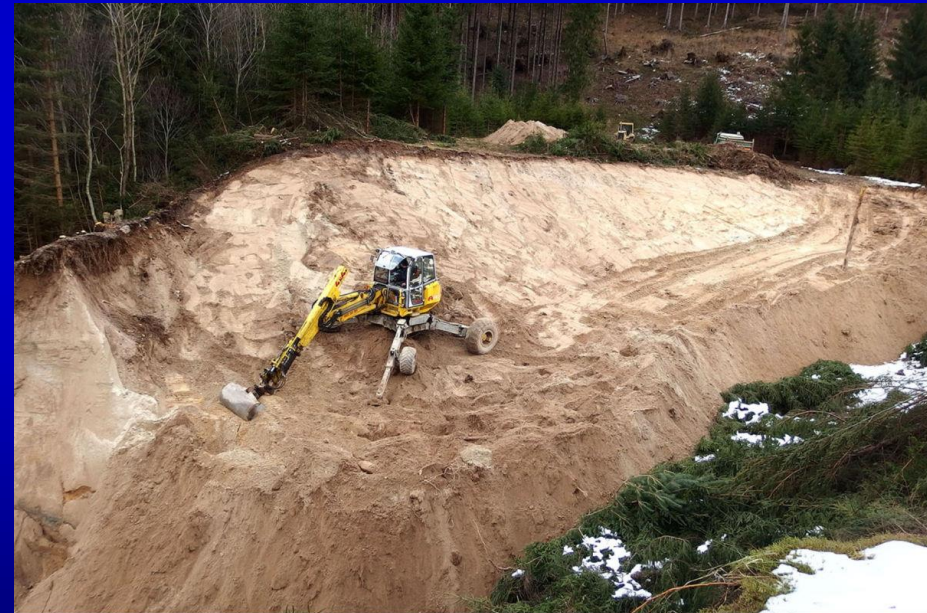
Sanácia havárie na odkalisku ložiska Dúbrava
