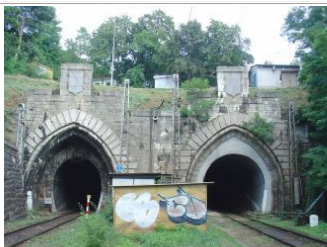
Lamačské portály Bratislavských tunelov foto Miroslav Kožuch, 10.8.2004 vľavo nový, vpravo starý tunel
