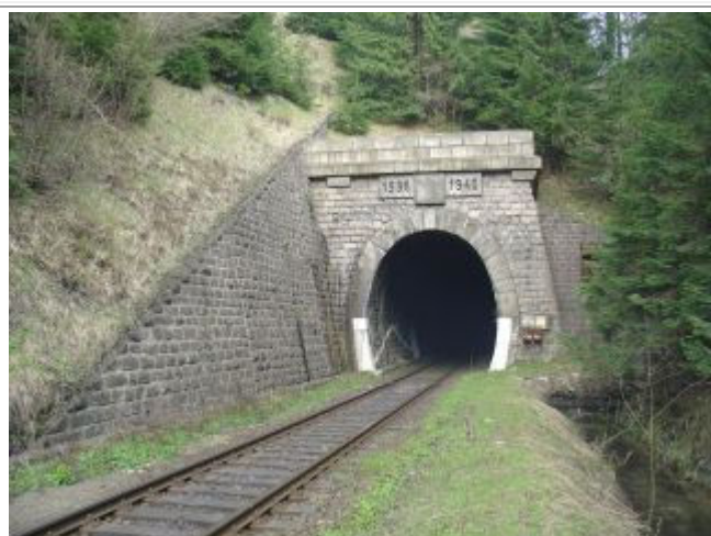
Čremošniarsky portál Čremošniarskeho tunela foto Miroslav Kožuch, 5.5.2006
