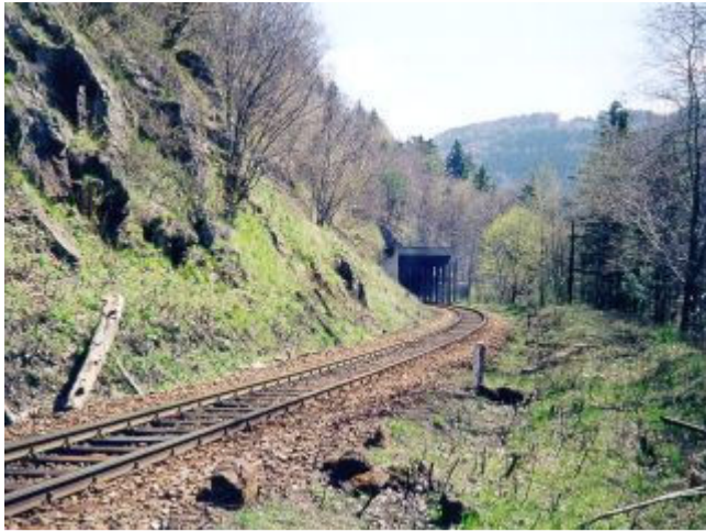
Vstup trate do galérie tunela Sohler foto Emil Schenk, 29.4.2001
