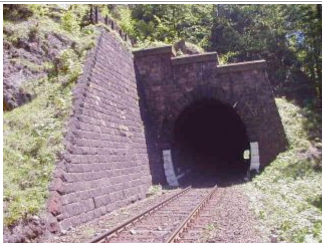
Ravnobežné krídlo Rábkinskeho tunela s odstupňovanou korunou foto Miroslav Kožuch, 24.5.2003
