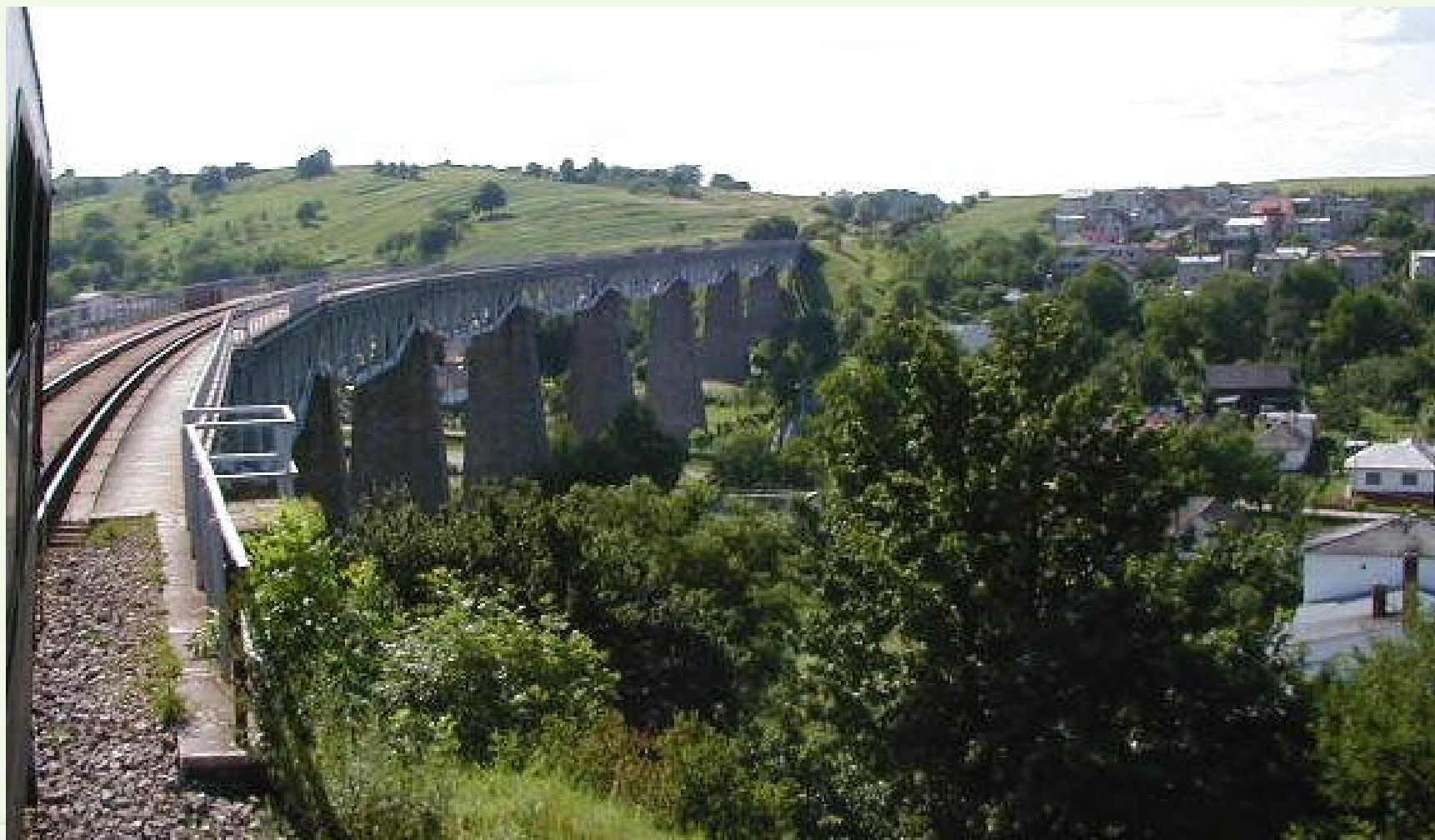
Hanušovský viadukt, 389,9 m (1943)
