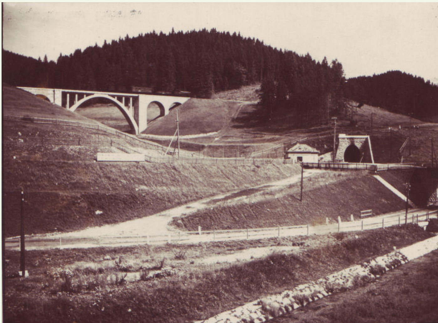
Telgártsky viadukt, 86,2 m, oblúk 32 m, svetlosť 22 m (1934)
