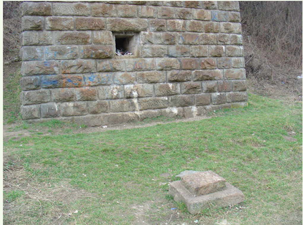
náložová komora na Kostiviarskom viadukte
