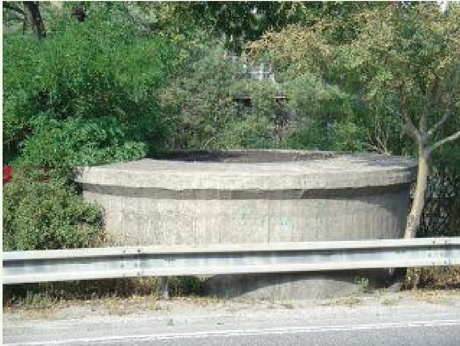
Vetracia šachta na Pražskej ceste (hĺbka 33 m)
