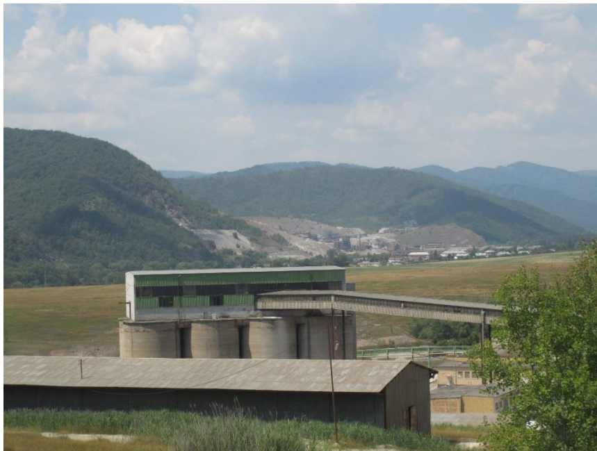
Rekultivované odkalisko (horizontálna plocha v strede) a staré horninové odvaly v okolí ložiska magnetitu pri Jelšave
