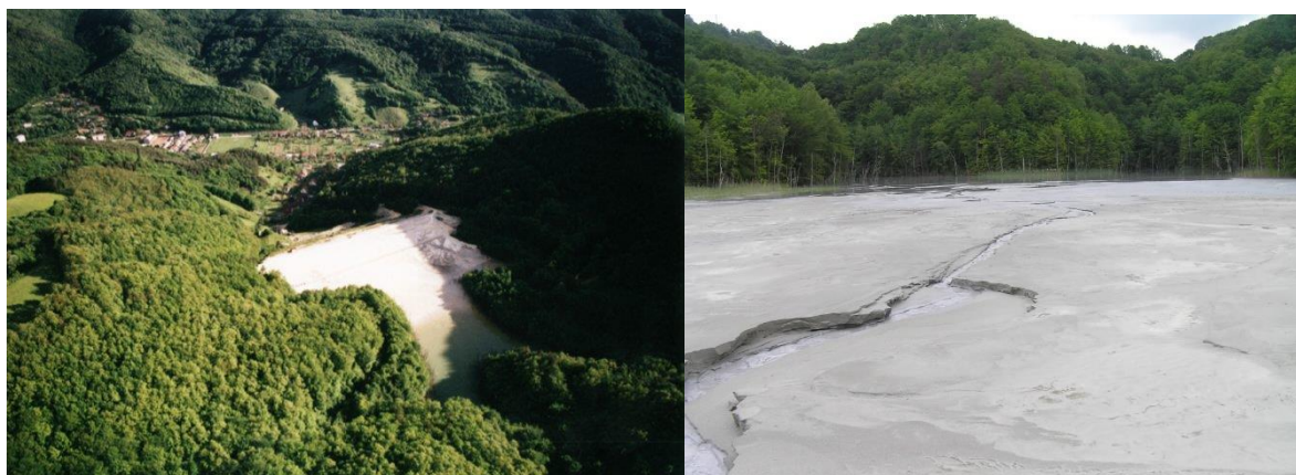
Odkaľisko v Hodruši z miestnej flotačnej úpravne Au –rudy, celkový pohľad a vzhľad naplaveného materiálu.
