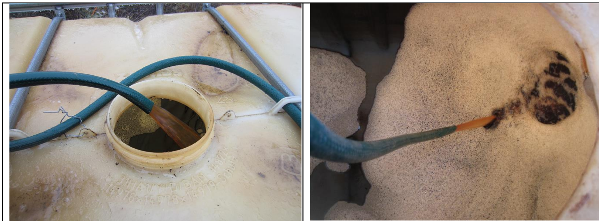
Obrázok 3 Odčerpávanie VFRL ponorným čerpadlom z vrtu a dočasne uskladnenie v IBC nádobe
