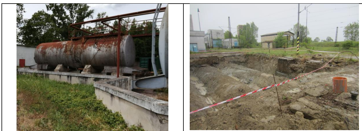
Obrázok 1 Nadzemné nádrže na naftu v rušňovom depe Leopoldov, podzemné nádrže v rušňovom depe v Štúrove
