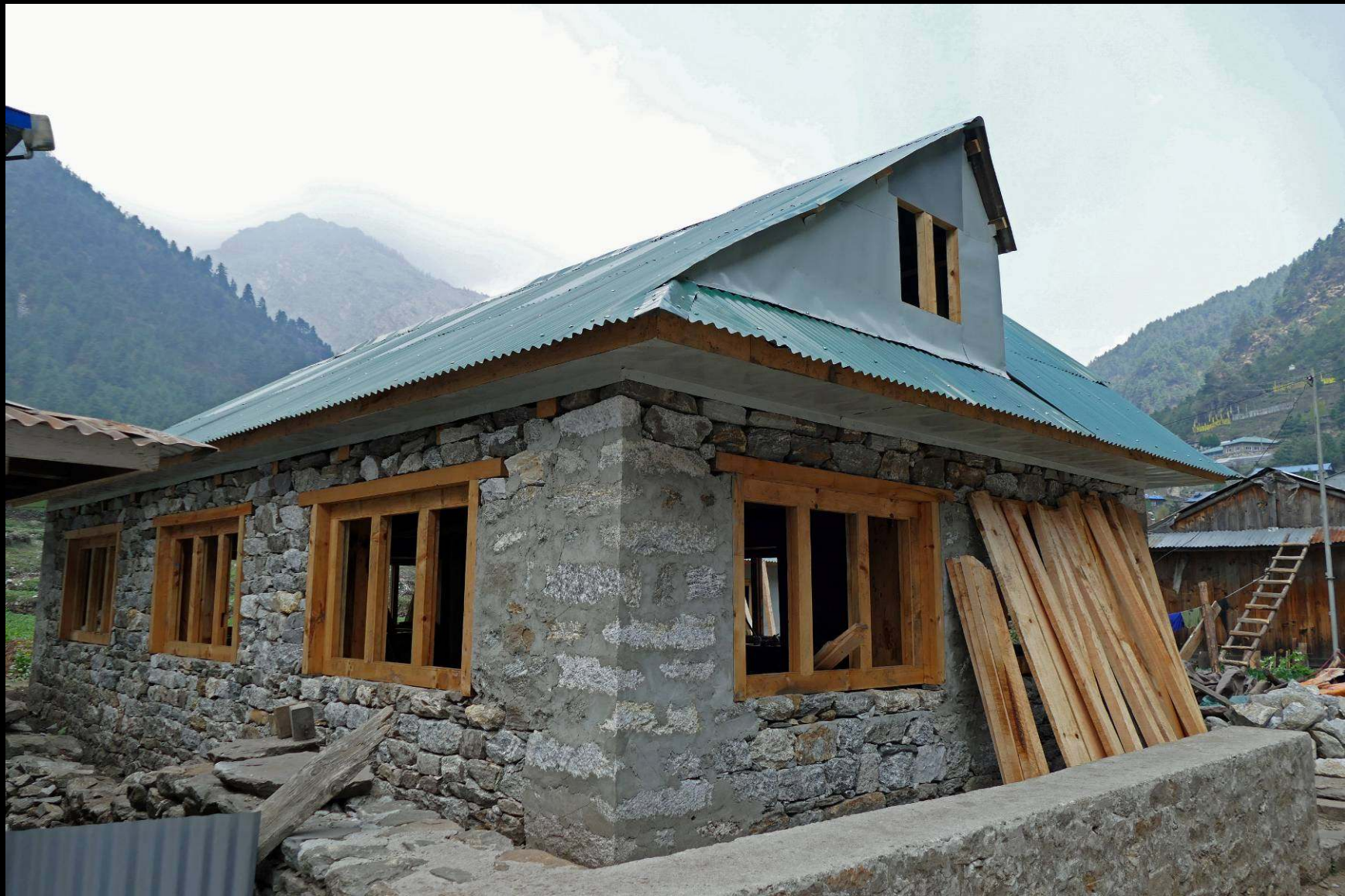
Seizmické „zodolnenie“ nových stavieb: betónovanie rohov nosných múrov
