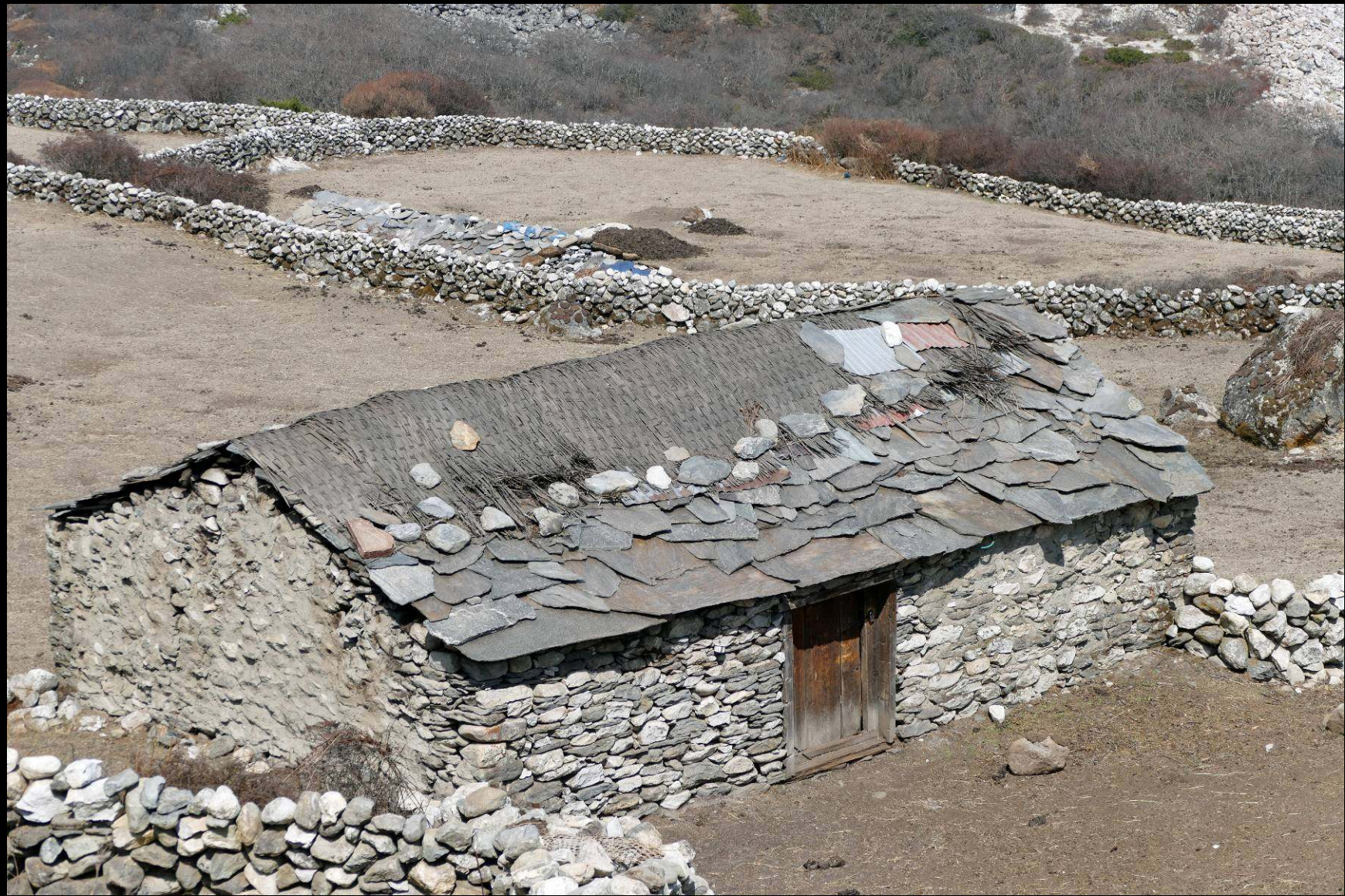
Kamenná stajňa pre dobytok vo výške 4100 m
