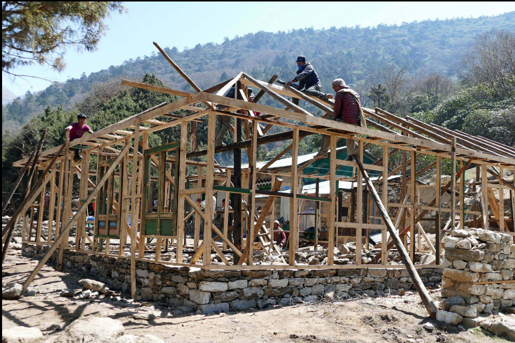
Milingo – výstavba nových, odlehčených domov po zemetrasení
