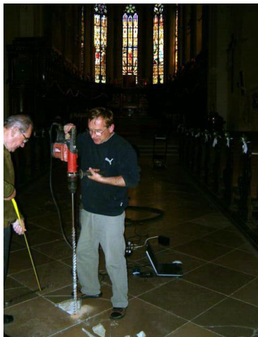
1. vrtanie po odkrytí dlažby
