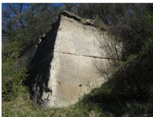
Roh lomovej steny
