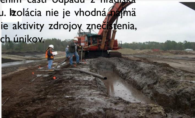
Obrázok 29: a - Inštalácia kalovej steny, Whitehouse, Florida, b - Konštrukcia vertikálnej steny pomocou rezačky Bauer Panel Cutter, Brunswick.
